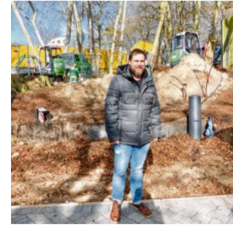
Andreas Flick, kaufmännischer Geschäftsführer der Vorpommerschen Landesbühne, erläuterte die Baumaßnahmen.
